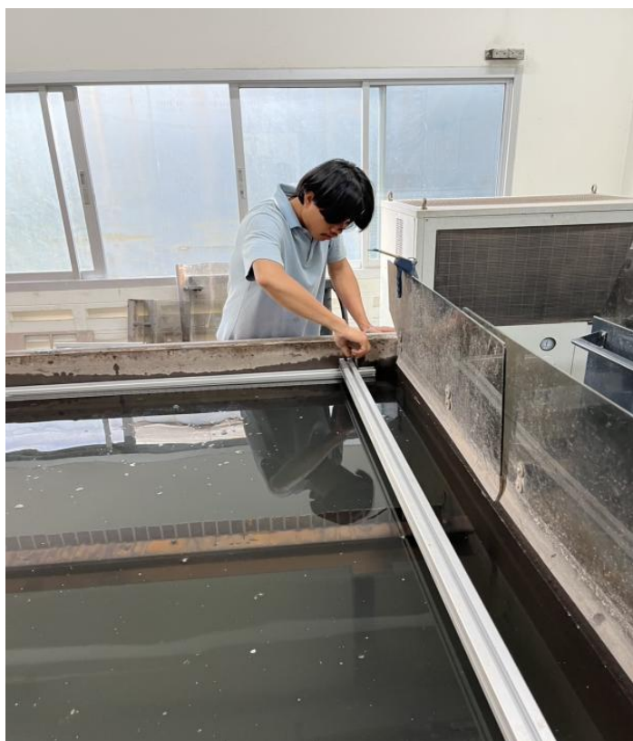
ภาพที่ 3.6.3 ภาพแสดงการติดตั้ง Aluminium Profile
