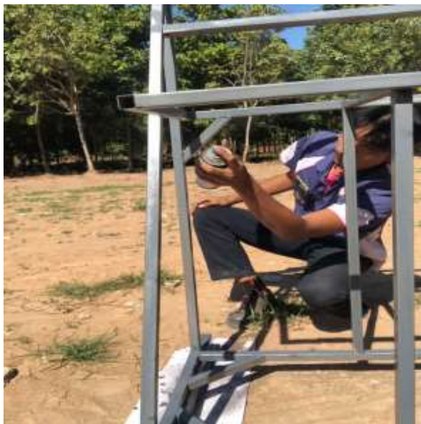
ภาพการดำเนินงานที่ 4 พ่นสีโครงสร้าง (ที่มา : นางสาวชมพูนุช แม่นงาม และคณะ : 2567)
