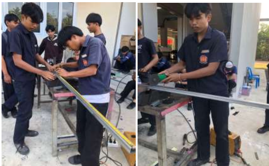
ภาพการดำเนินงานที่ 1 วัดและตัดเหล็กให้ได้ขนาด (ที่มา : นางสาวชมพูนุช แม่นงาม และคณะ : 2567)
