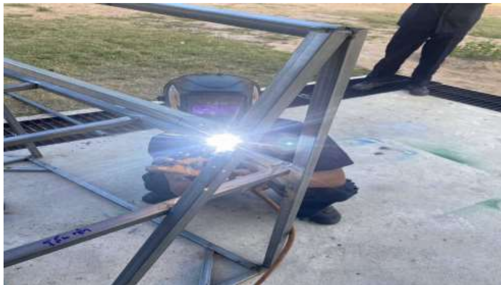
ภาพที่ 3.3 ขั้นตอนการเชื่อมชิ้นโครง (ที่มา : นางสาวชมพูนุช แม่นงาม และคณะ : 2567)
