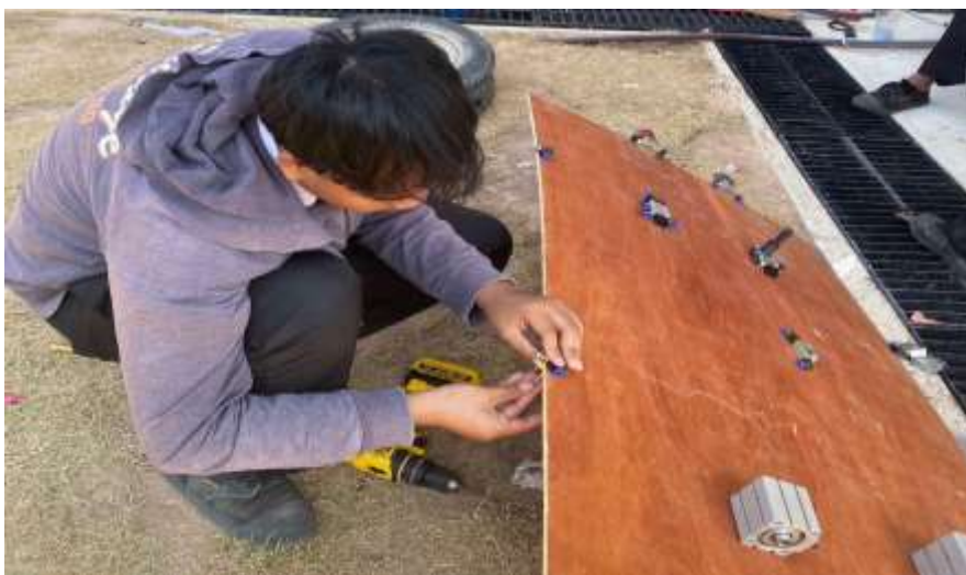
ภาพการดำเนินงานที่ 6 ล็อกและติดตั้งวาล์วลม (ที่มา : นางสาวชมพูนุช แม่นงาม และคณะ : 2567)
