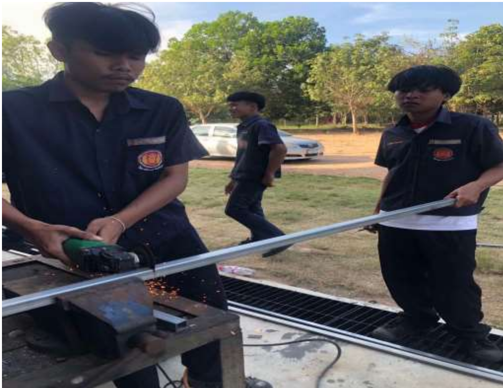
ภาพที่ 3.1 ขั้นตอนการตัดเหล็ก
