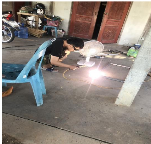
ภาพที่ 3.3 เชื่อมเหล็กขึ้นโครง
