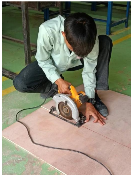
ขั้นตอนที่ 4 ทำการตัดไม้อัด
