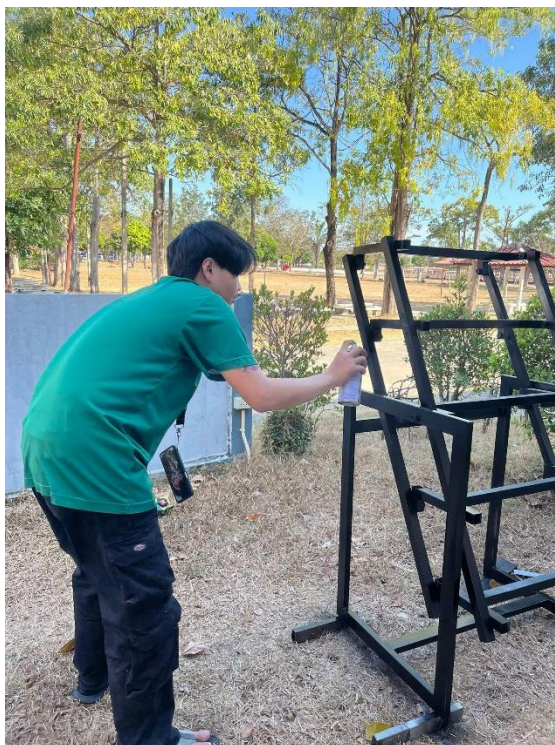
ขั้นตอนที่ 4 ทำการพ่นสีโครงสร้างชั้นวางของ
