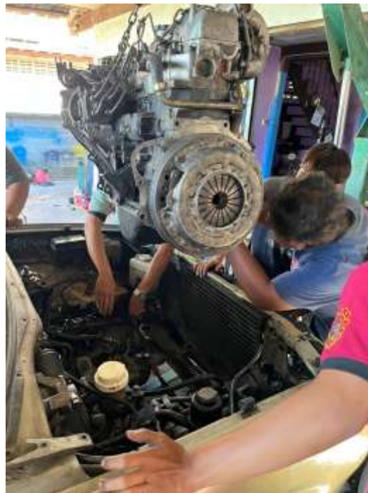
รูปภาพที่ 4.23 ยกเครื่องใส่บอดีรถ
