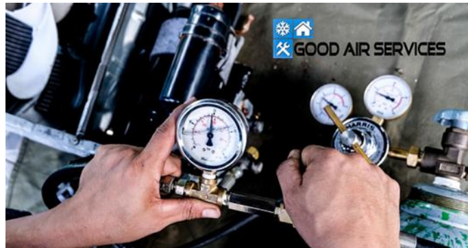
ภาพที่ 4.4 การตรวจหารอยรั่ว
