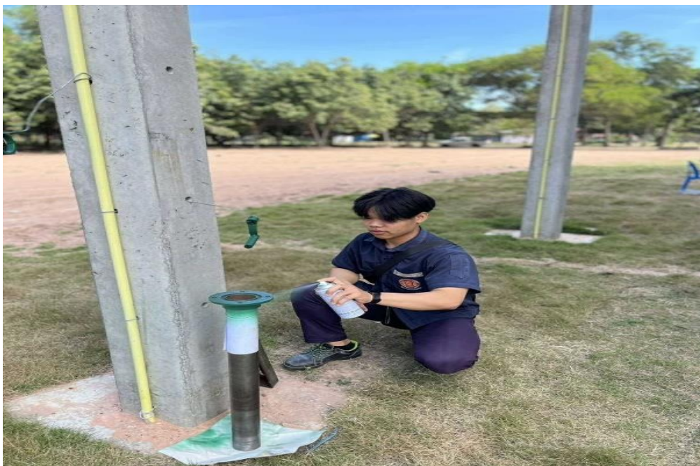
ภาพการดำเนินงานที่ 3.3 ลงสีตัวที่ตั้งต่อกับฐาน ( ที่มา : นายตรีทศ ปัดทาศรี และคณะ : 2567 )
