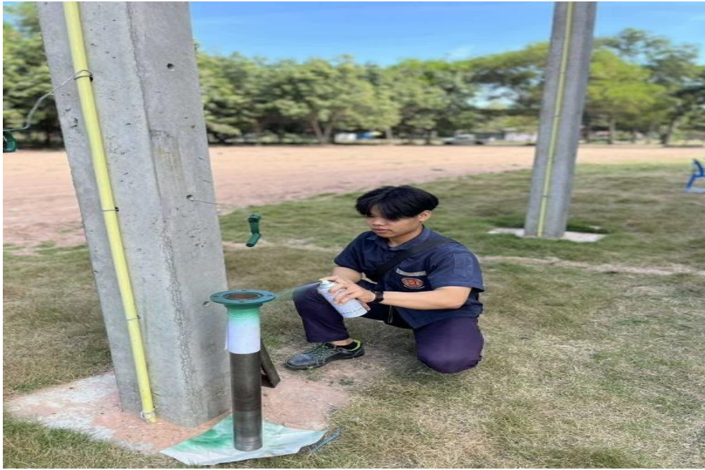
ภาพการดำเนินงานที่ 3.3 นำกระดาษทรายขัดเศษฝุ่น สนิม ตัวฐานกับวงแหวนตัวฐานออก ( ที่มา : นายตรีทศ ปัดทาศรี และคณะ : 2567 )
