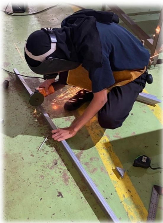
ขั้นตอนที่ 2 ทำการตัดเหล็กเพื่อขึ้นโครงรถเข็น
