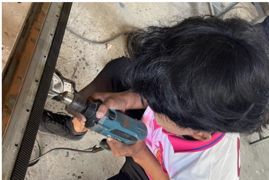
รูปภาพที่ 3.4 เจาะรูเพื่อที่จะติดตั้งเฟืองสะพานใหม่ ( ที่มา : วุฒิชัย สุขสัน,2567 )
