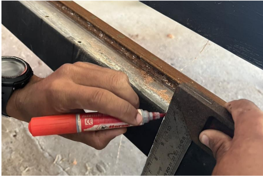
รูปภาพที่ 3 วัดหาระยะเพื่อที่จะติดตั้งเฟืองสะพาน ( ที่มา : วุฒิชัย สุขสัน,2567 )
