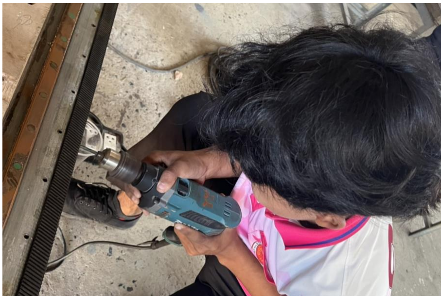
รูปภาพที่ 4 เจาะรูเพื่อที่จะติดตั้งเฟืองสะพานใหม่ ( ที่มา : วุฒิชัย สุขสัน,2567 )
