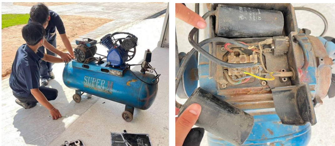
ภาพที่3.5 ศึกษาระบบของปั๊มลม และตรวจสอบอุปกรณ์ที่ชำรุดเสียหาย
