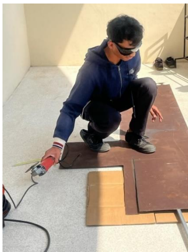
ภาพที่ 3.1 การขึ้นโครงสร้างแบบ
