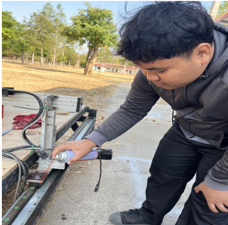
รูปภาพที่ 1 ใช้ Sonax ฉีดลงในรางสไลด์ที่เกิดสนิม ( ที่มา: นิธิศ จันทะคาม และคณะ2568 )
