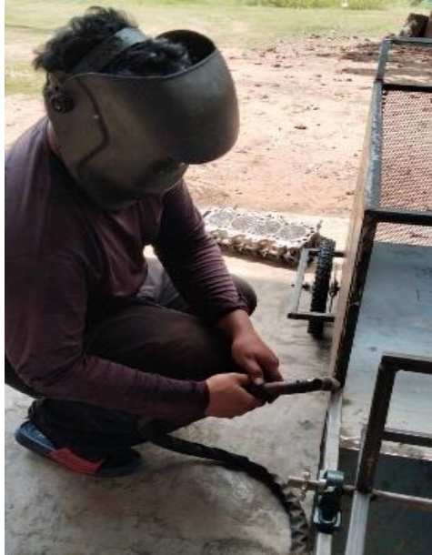
ภาพที่ 1.ดำเนินการเชื่อมชุดเพลารถกวาดใบไม้เพื่อทำหน้าที่กวาดเศษใบไม้และกิ่งไม้ขนาดเล็ก
