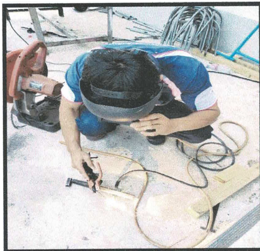
ภาพดำเนินงานที่ 2 ทำการเชื่อมโครงสร้าง (ที่มา: นายยศวรธรณ์ แดนกาไสยและคณะผู้จัดทำ 2567)
