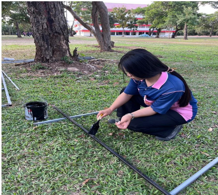
รูปภาพที่ 4 แสดงภาพการทาสีโครงเหล็ก
