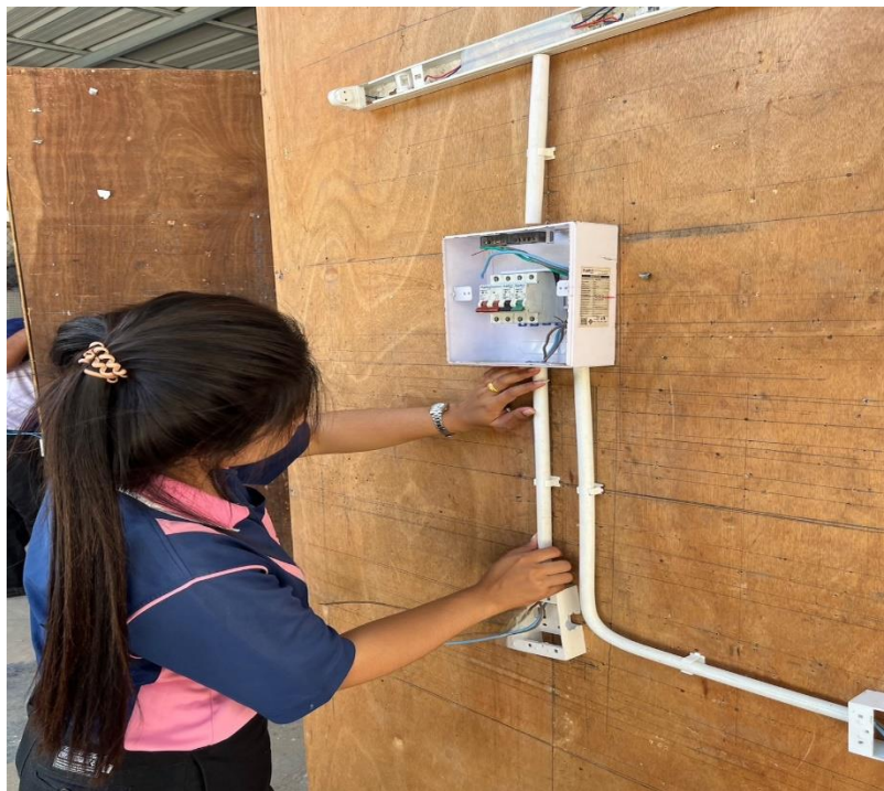
รูปภาพที่ 18 แสดงภาพการใส่ท่อยึดติดกับก้ามปู
