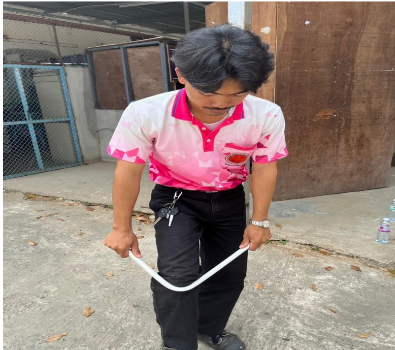
รูปภาพที่ 17 แสดงภาพการดัดท่อเพื่อร้อยท่อเข้าสู่ตู้คอนซูมเมอร์
