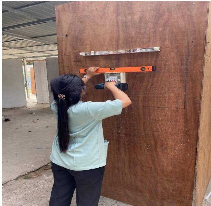
รูปภาพที่ 11 แสดงภาพการติดตั้งตู้คอนซูมเมอร์
