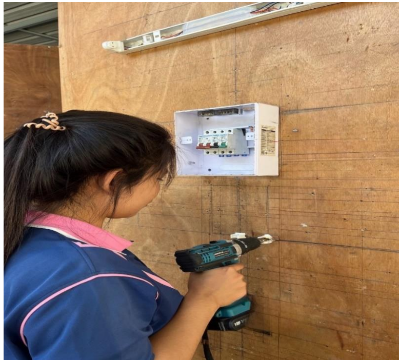
รูปภาพที่ 15 แสดงภาพการยิงสกรูยึดซีแคม
