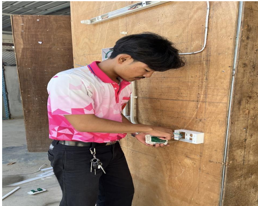
รูปภาพที่ 23 แสดงภาพการต่อสายไฟเข้าเต้ารับ
