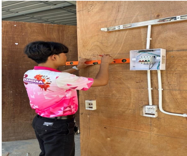
รูปภาพที่ 19 แสดงภาพการวัดกระดานเพื่อจะใส่ราง
