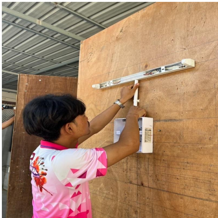
รูปภาพที่ 11 แสดงภาพการติดตั้งตู้คอนซูมเมอร์
