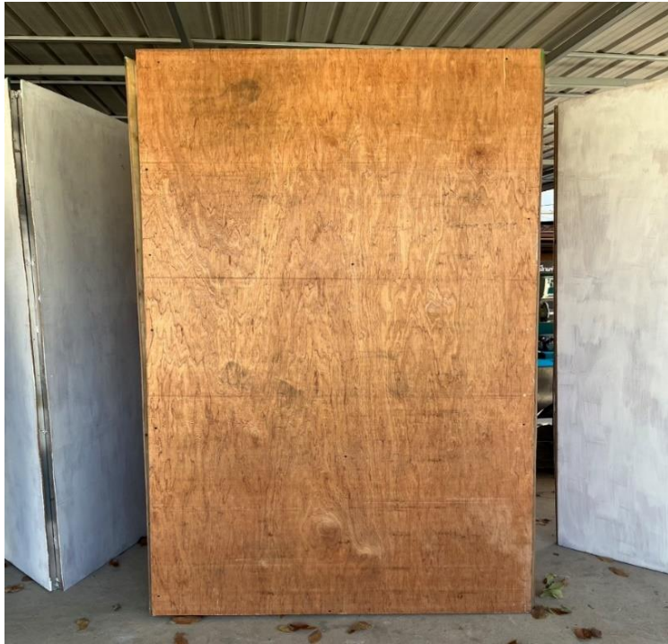
รูปภาพที่ 8 แสดงภาพการติดกระดานไม้อัดเสร็จแล้ว
