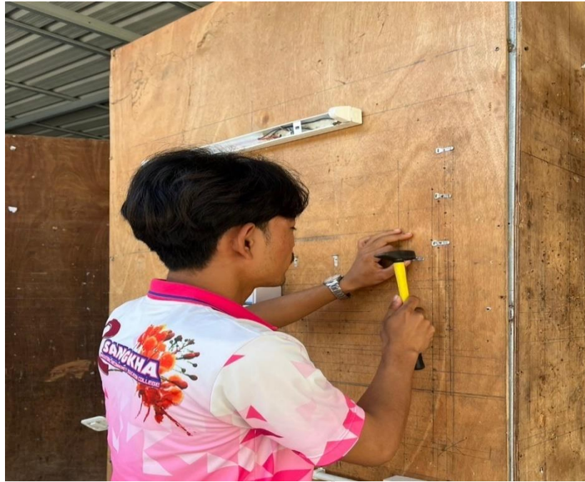
รูปภาพที่ 13 แสดงภาพการตีก๊ิปเพื่อเดินสายไปยัง L 2
