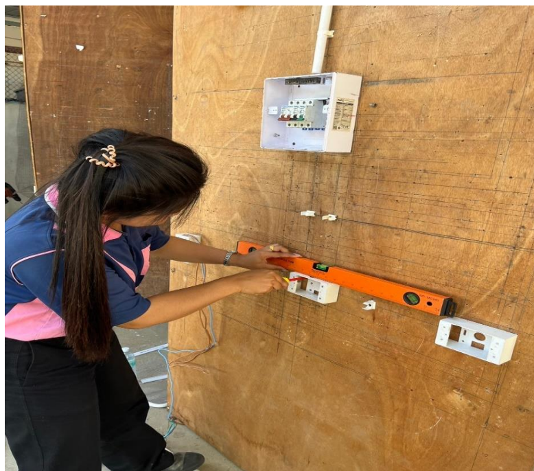
รูปภาพที่ 16 แสดงภาพการติดบล็อกลอย
