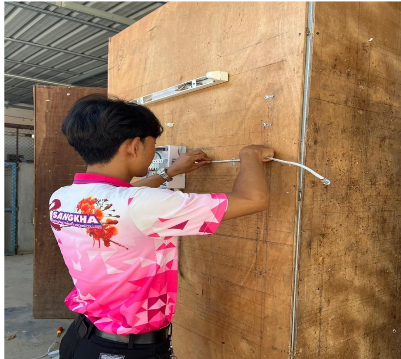
รูปภาพที่ 14 แสดงภาพการแทบสายไฟเพื่อเข้าหลอดไฟ L
