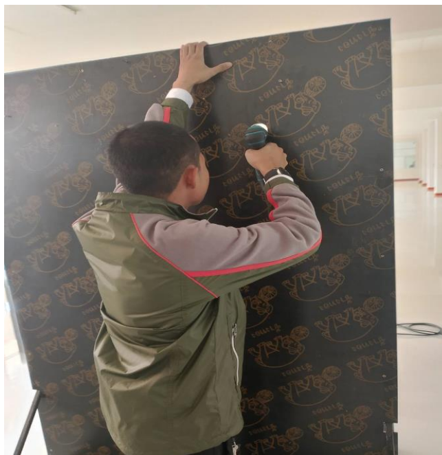
รูปภาพที่ 9 เจาะรูเพื่อนำชุดแอร์ด้านหน้ามาประกอบ
