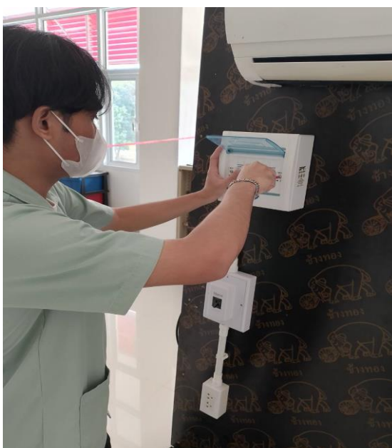
รูปภาพที่ 17 ประกอบและปิดฝา เซอร์กิตเบรกเกอร์
