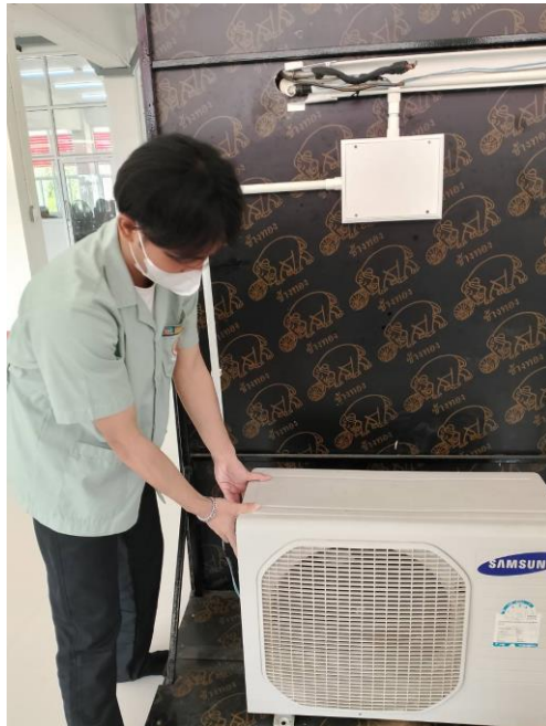
รูปภาพที่ 18 ดำเนินการติดตั้งชุดแอร์ด้านหลัง
