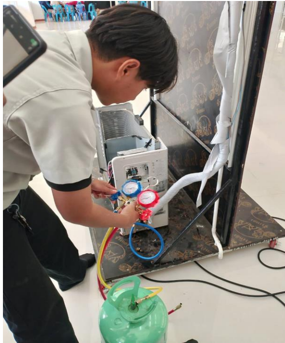
รูปภาพที่ 22 เติมน้ำยาหล่อเย็น และทดสอบการทำงาน
