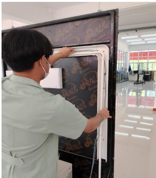
รูปภาพที่ 13 ติดตั้งท่อและสายไฟด้านหลัง
