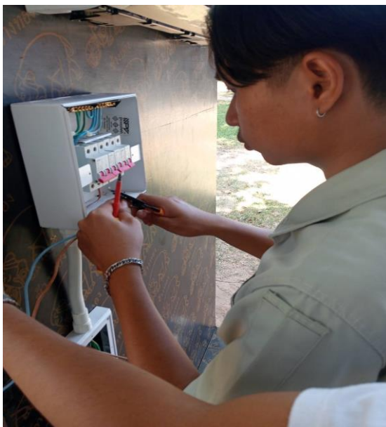
รูปภาพที่ 16 ติดตั้ง เซอร์กิตเบรกเกอร์ ด้านหน้า
