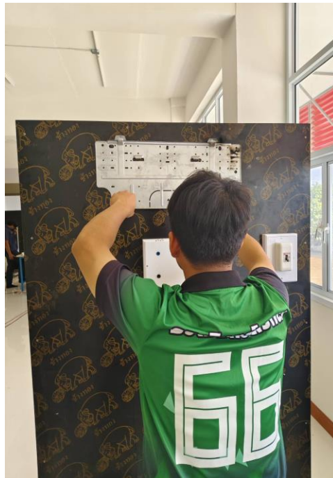
รูปภาพที่ 10 ติดตั้งแผ่นแปด เพื่อติดตั้งชุดแอร์ด้านหน้า
