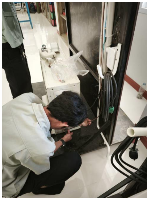
รูปภาพที่ 19 เชื่อมต่อท่อเข้ากับชุดแอร์ด้านหลัง
