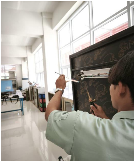
รูปภาพที่ 14 เดินท่อและสายไฟชุดส่วนประกอบแอร์ด้านหลัง
