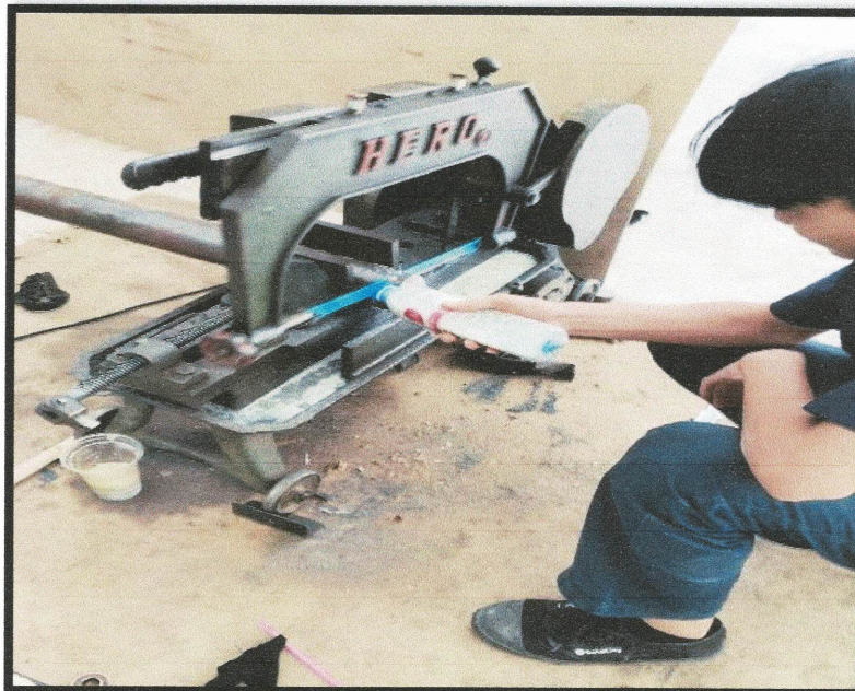
รูปที่ 3.1 การตัดเหล็ก (ที่มานายณัฐพล พิลัย พร้อมคณะผู้จัดทำ 2567)
