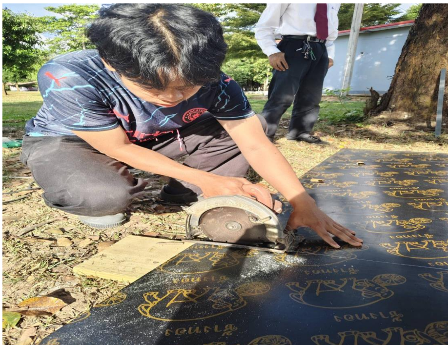
รูปภาพที่ 6 แสดงการนำกระดานไม้อัดมาตัดเพื่อประกอบกับเหล็กที่เชื่อม
