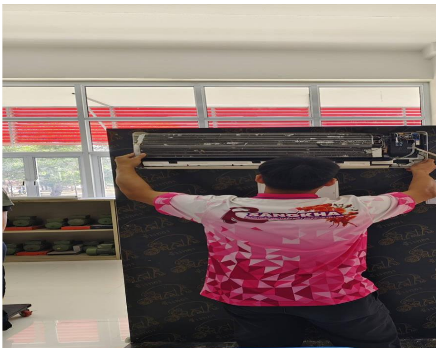
รูปภาพที่ 10 แสดงการติดตั้งชุดแอร์ด้านหลัง
