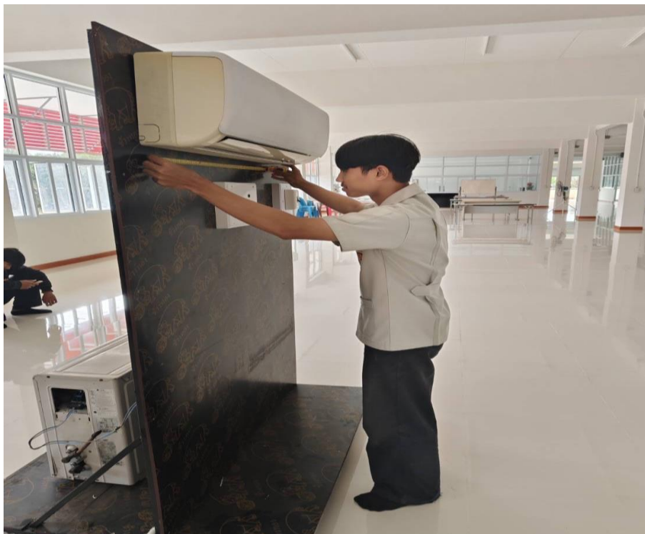
รูปภาพที่ 14 แสดงการนำฝาด้านหน้ามาประกอบและทดลองใช้งาน
