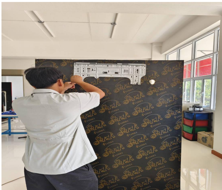
รูปภาพที่ 9 แสดงการเจาะรูเพื่อนำชุดแอร์ด้านหน้ามาประกอบ
