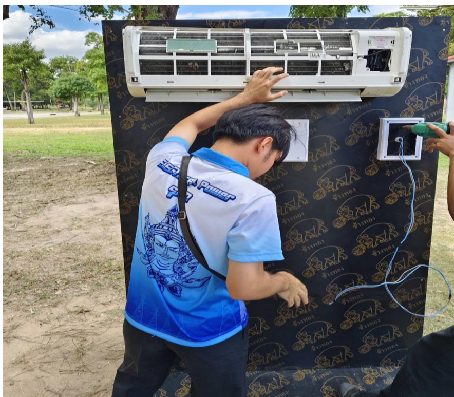
รูปภาพที่ 11 แสดงการติดตั้งชุดแอร์ด้านหลัง
