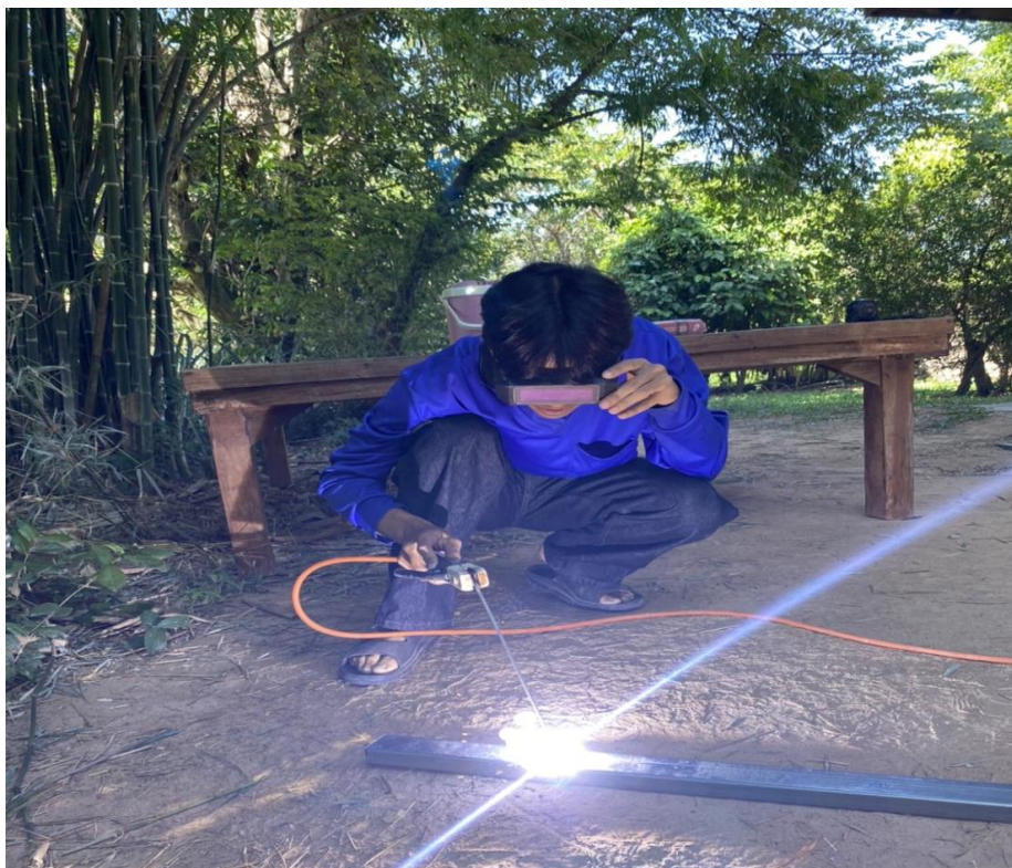
รูปภาพที่ 4 แสดงการวัดขนาดและทำการเชื่อมเหล็กขึ้นโครง
