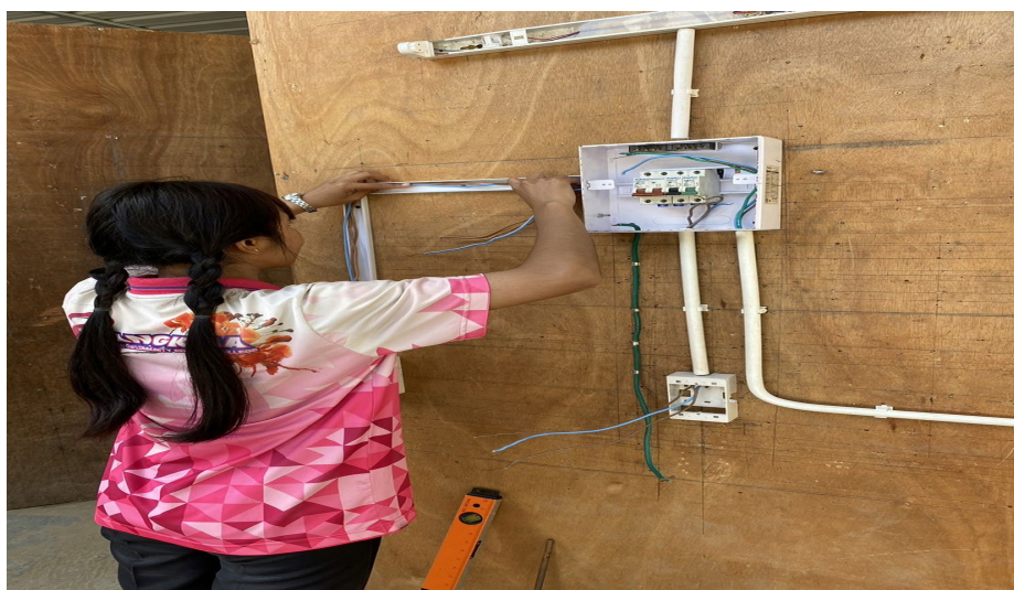
รูปภาพที่ 18 เดินสายไฟเข้าสู่ตู้คอนซูเมอร์ยูนิต
