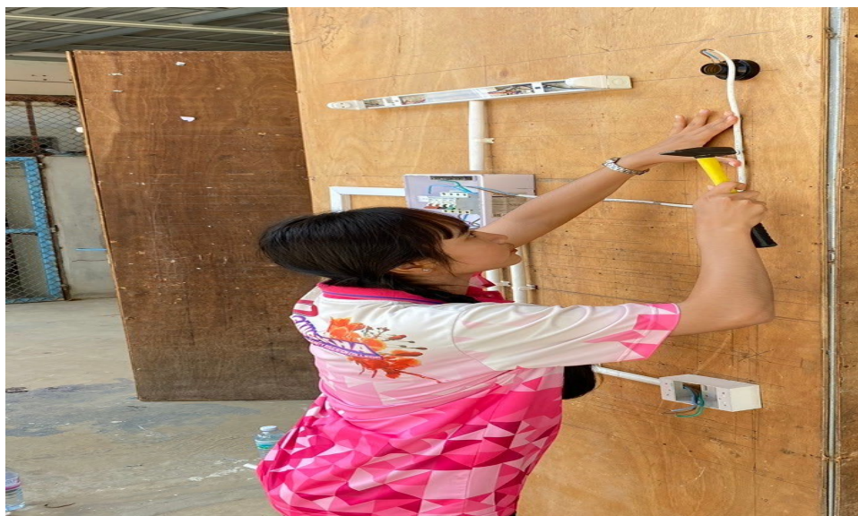
รูปภาพที่ 14 แสดงภาพการเดินสายไปยังหลอดไฟ L2
