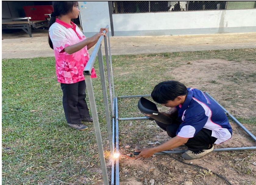
รูปภาพที่ 5 นำเหล็กที่เชื่อมไว้มาประกอบโครง
