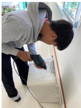
ภาพที่ 3.2 เจาะรูระบายอากาศ
