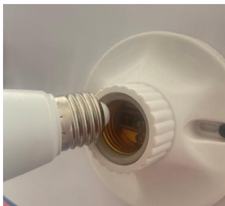
ภาพที่ 3.4 การติดตั้งหลอดไฟ
