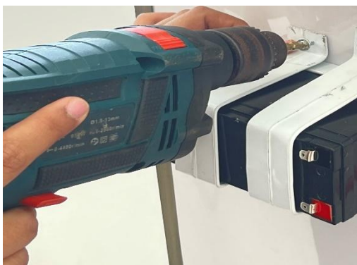
ภาพที่ 3.5 การติดตั้งแบตเตอรี่
