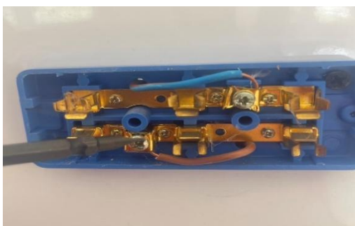
ภาพที่ 3.6 การติดตั้งปลั๊กไฟ
