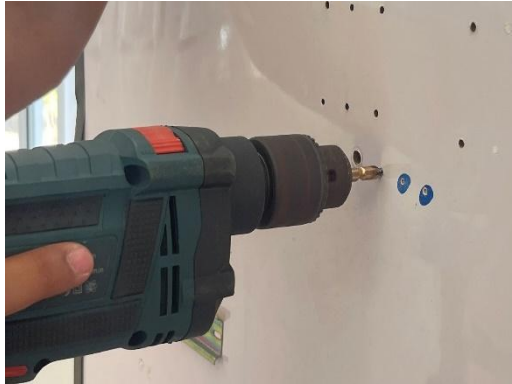
ภาพที่ 3.7 การเจาะรูต่อสายไฟ
