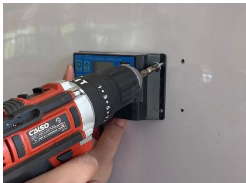
ภาพที่ 3.2 การติดตั้งคอนโทรล ชาร์จเจอร์
