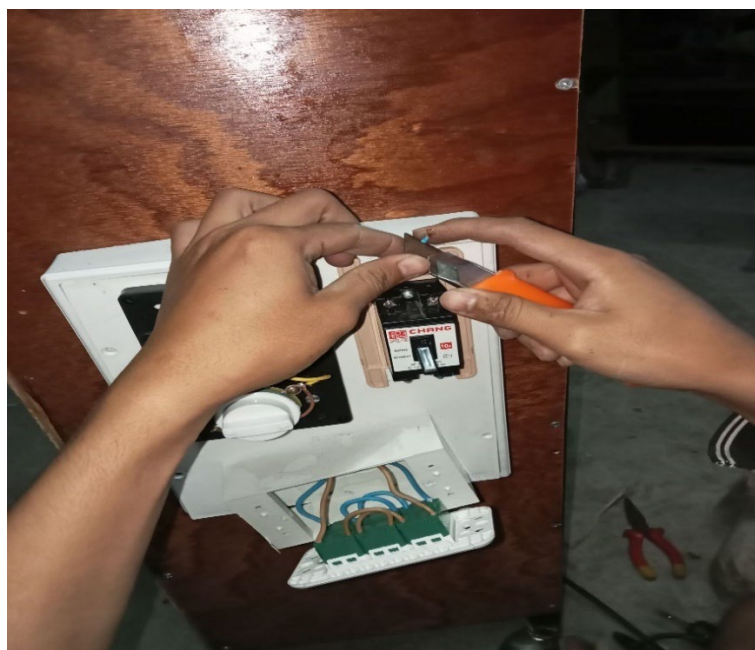
รูปภาพที่ 8 แสดงภาพการติดตั้งปลั๊กและเบรกเกอร์
