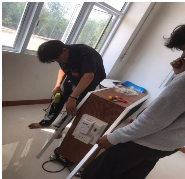
รูปภาพที่ 9 แสดงภาพการติดตั้งฉากเหล็กปิดขอบ
