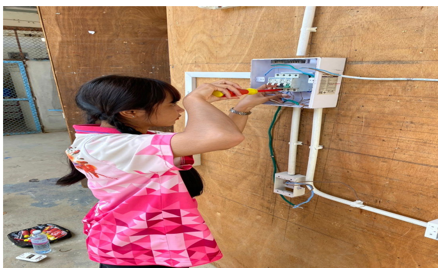
รูปภาพที่ 20 เดินสายไฟเข้าตู้คอนซูเมอร์ยูนิตในแผงสาธิตชุดสอบมาตรฐานฝีมือแรงงาน
