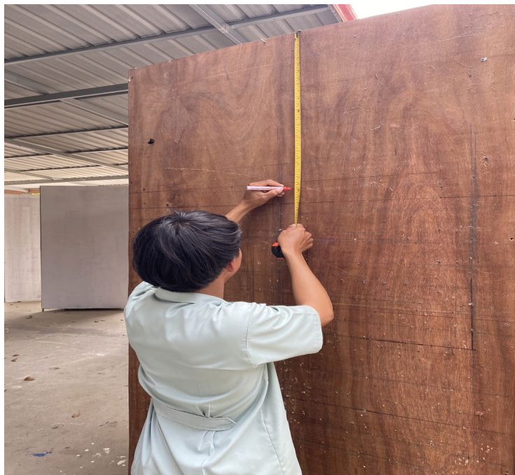
รูปภาพที่ 8 วัดขนาดกระดานเพื่อติดตั้งหลอดไฟ L1
