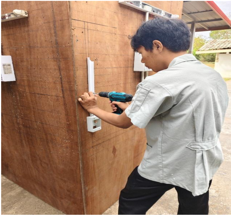
รูปภาพที่ 7 แสดงการติดตั้งรางเก็บสายไฟ
