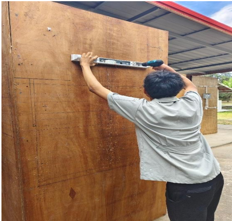
รูปภาพที่ 1 แสดงการติดตั้งหลอดไฟฟลูออเรสเซนต์
