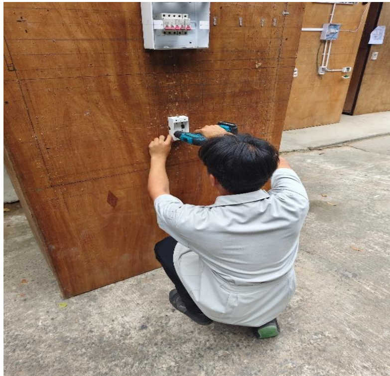
รูปภาพที่ 3 แสดงการติดตั้งปลั๊กลอย
