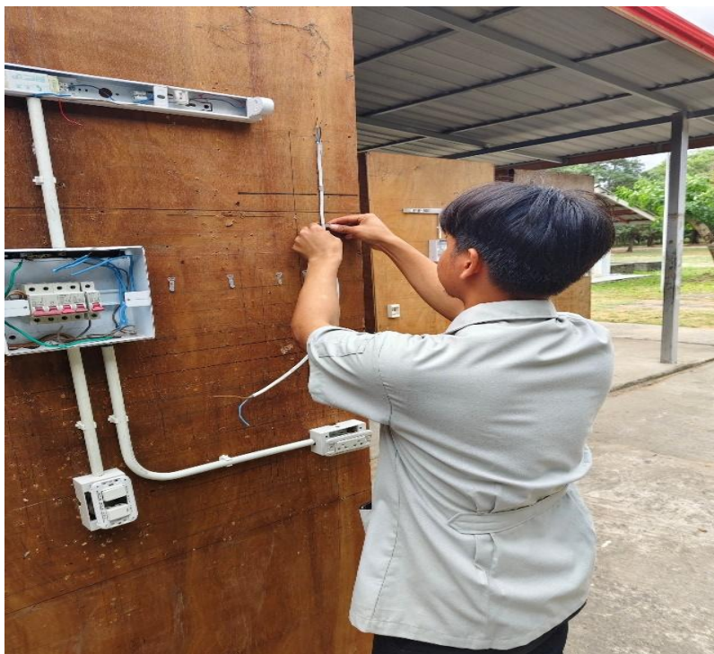
รูปภาพที่ 10 แสดงการเก็บสายไฟ
