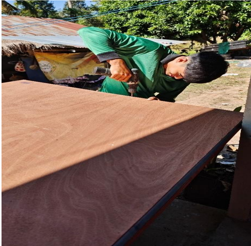
รูปภาพที่ 5 แสดงขั้นตอนการยิงสกรูยึดไม้อัด
