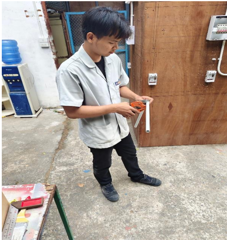
รูปภาพที่ 5 แสดงการตัดท่อ
