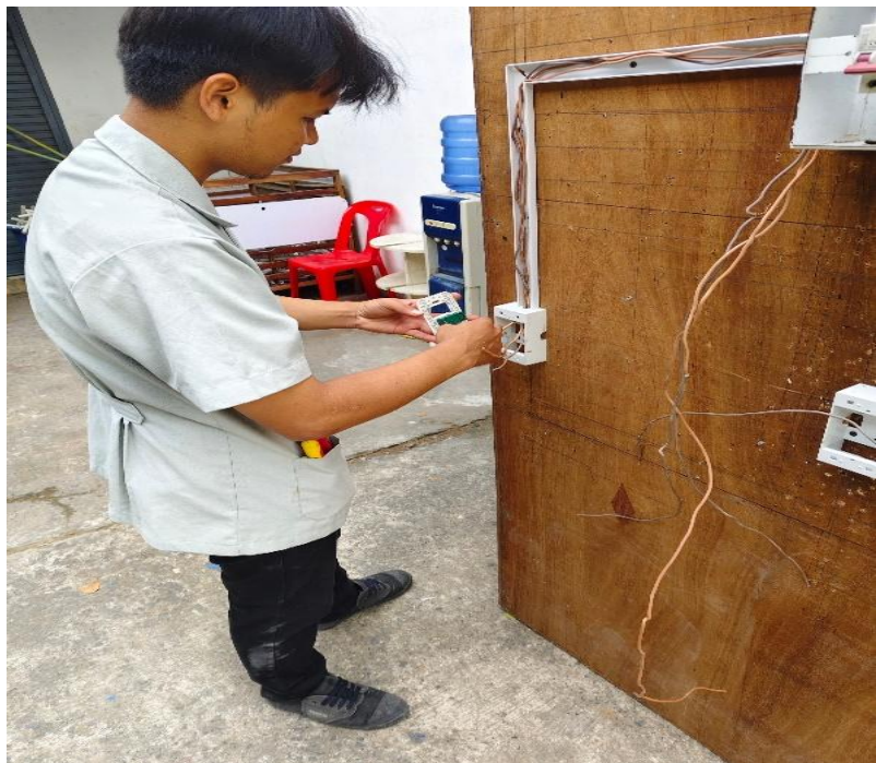
รูปภาพที่ 18 แสดงการติดตั้งสวิตช์สองทาง
