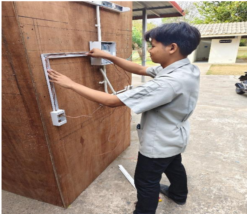
รูปภาพที่ 17 แสดงการเก็บสายไฟเข้าราง
