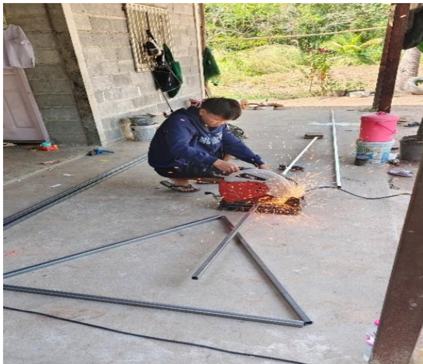
รูปภาพที่ 3 แสดงขั้นตอนการตัดเหล็ก
