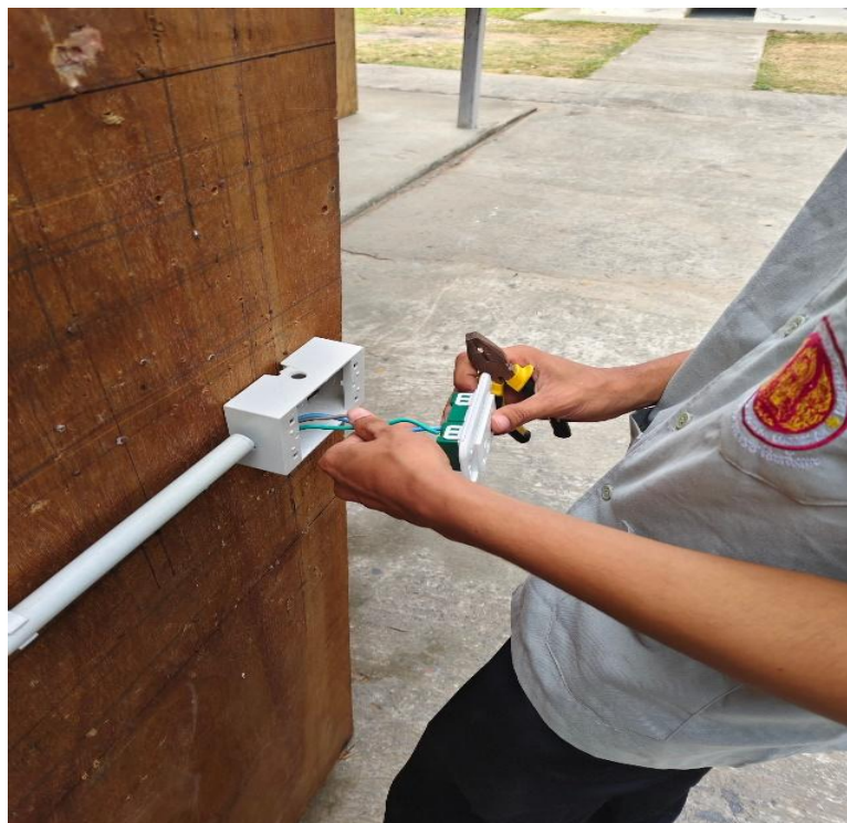
รูปภาพที่ 14 แสดงการติดตั้งเต้ารับ
