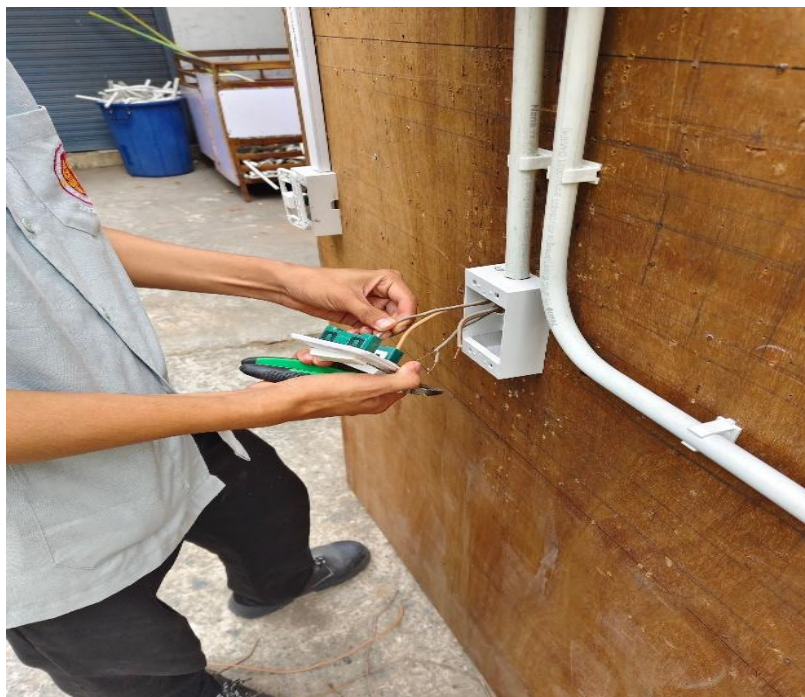
รูปภาพที่ 16 แสดงการติดตั้งสวิตช์สองทาง
