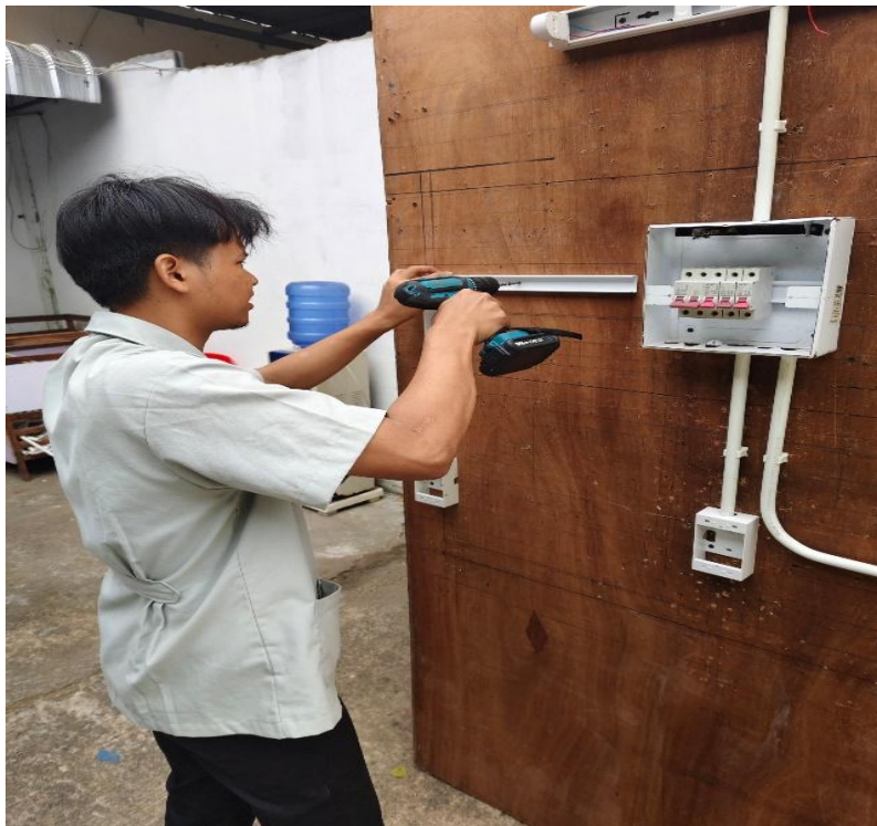
รูปภาพที่ 8 แสดงการติดตั้งรางเก็บสายไฟ
