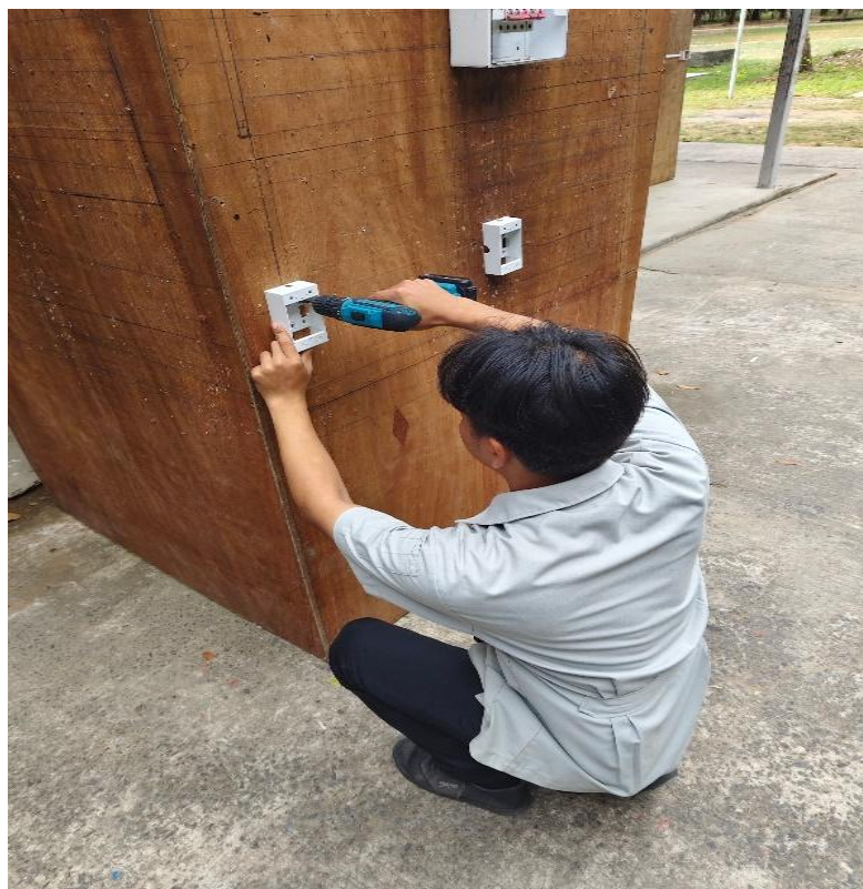
รูปภาพที่ 4 แสดงการติดตั้งปลั๊กลอย
