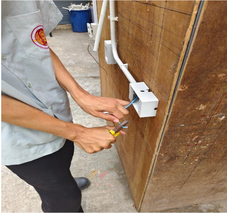
รูปภาพที่ 13 แสดงการปลอกสายไฟ
