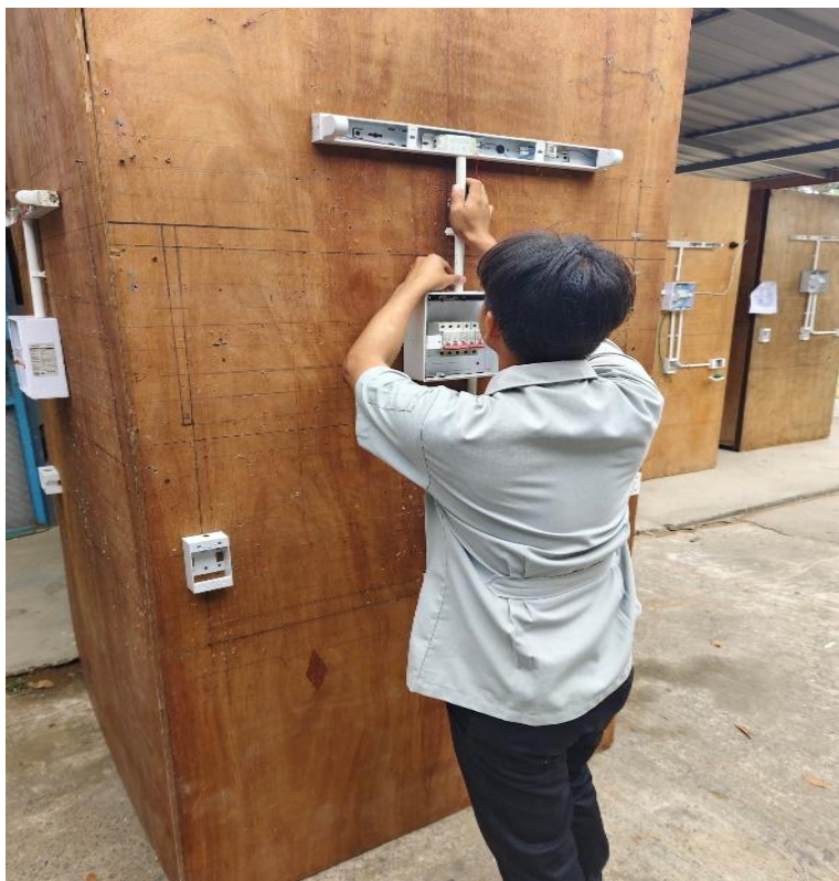
รูปภาพที่ 6 แสดงการติดตั้งท่อ
