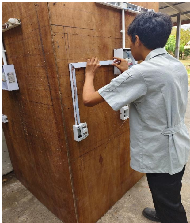
รูปภาพที่ 16 ปิดฝาครอบสายไฟชุดแผงสายิตชุดทดสอบมาตรฐานฝีมือแรงงาน
