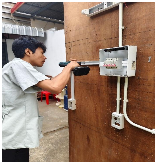
รูปภาพที่ 13 การติดตั้งรางสายไฟชุดแผงสวิตช์ชุดทดสอบมาตรฐานฝีมือแรงงาน
