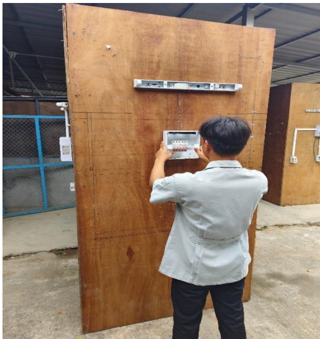
รูปภาพที่ 8 การติดตั้งตู้คอนซูมเมอร์ชุดแผงสาธิตชุดทดสอบมาตรฐานฝีมือแรงงาน
