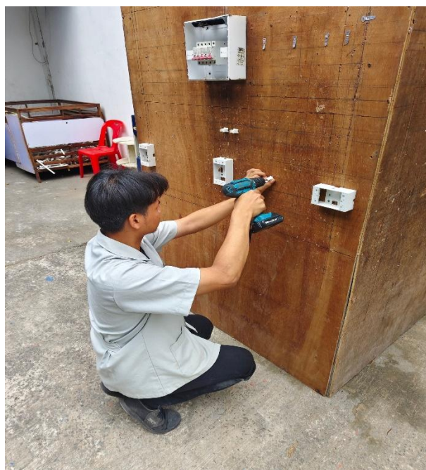
รูปภาพที่ 10 การติดตั้งแอมชุดชุดแผงสาธิตชุดทดสอบมาตรฐานฝีมือแรงงาน
