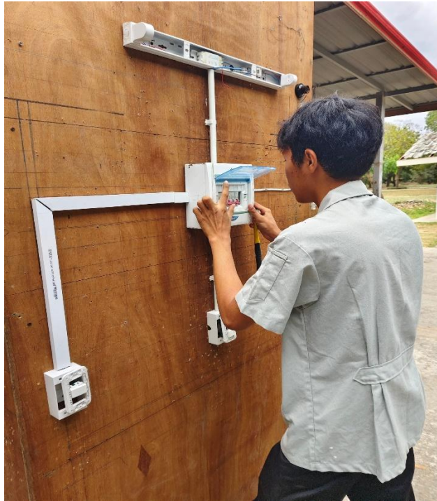
รูปภาพที่ 19 การติดตั้งฝาปิดตู้คอนซูมเมอร์ชุดแผงสาธิตชุดทดสอบมาตรฐานฝีมือแรงงาน
