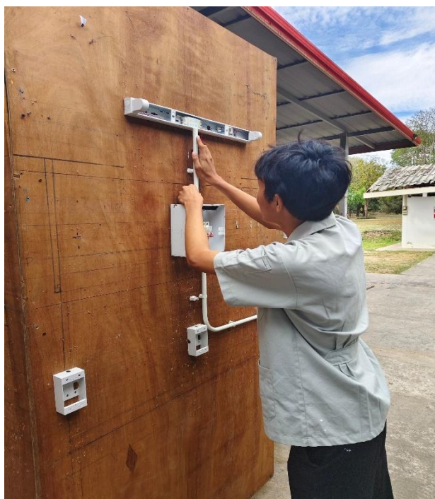
รูปภาพที่ 12 การติดตั้งท่อชุดแผงสาธิตชุดทดสอบมาตรฐานฝีมือแรงงาน
