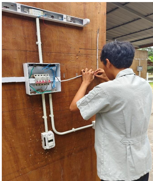
รูปภาพที่ 17 การตีกิบและเก็บสายไฟชุดแผงสาธิตชุดทดสอบมาตรฐานฝีมือแรงงาน
