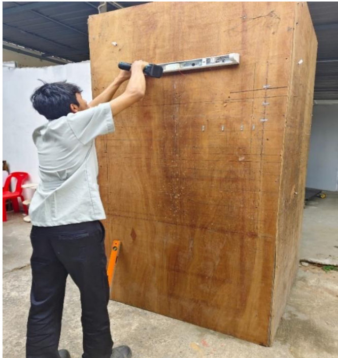
รูปภาพที่ 7 การติดตั้งหลอดไฟ L1 ชุดแผงสาธิตชุดทดสอบมาตรฐานฝีมือแรงงาน
