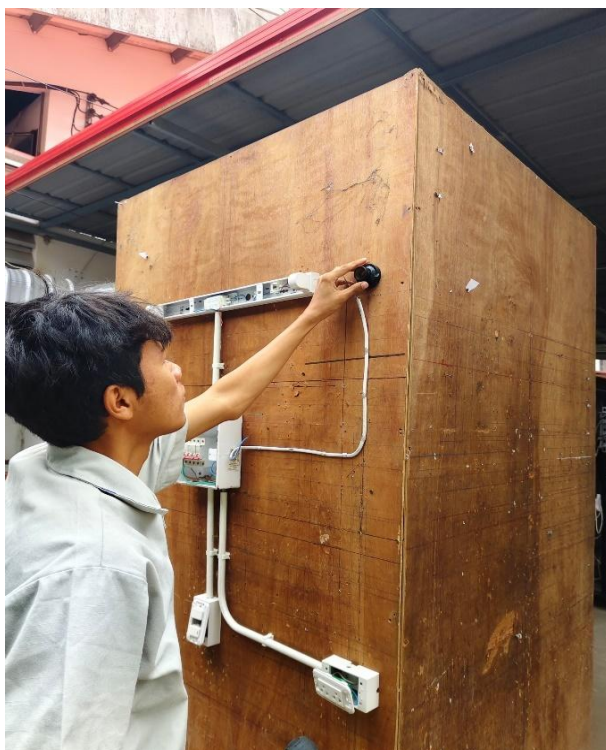
รูปภาพที่ 18 การติดตั้งหลอดไฟ L2ชุดแผงสาธิตชุดทดสอบมาตรฐานฝีมือแรงงาน
