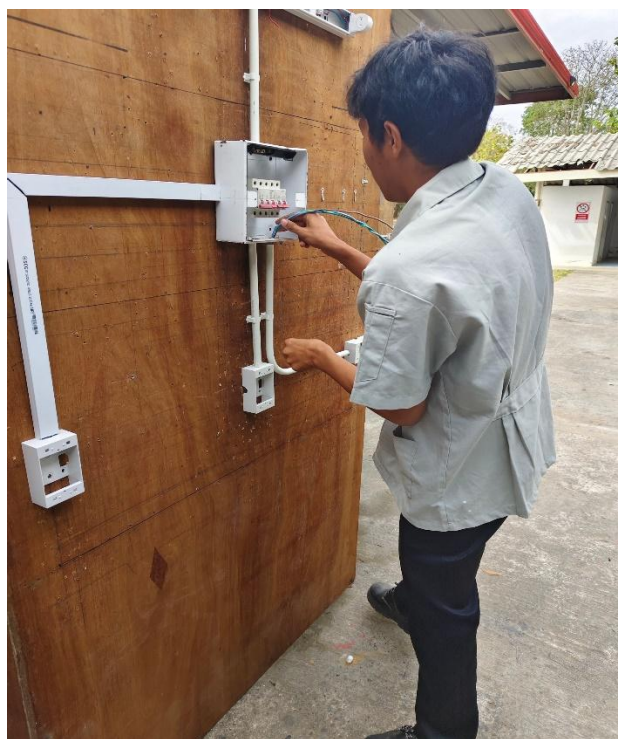
รูปภาพที่ 14 การร้อยสายไฟชุดแผงสวิตช์ชุดทดสอบมาตรฐานฝีมือแรงงาน
