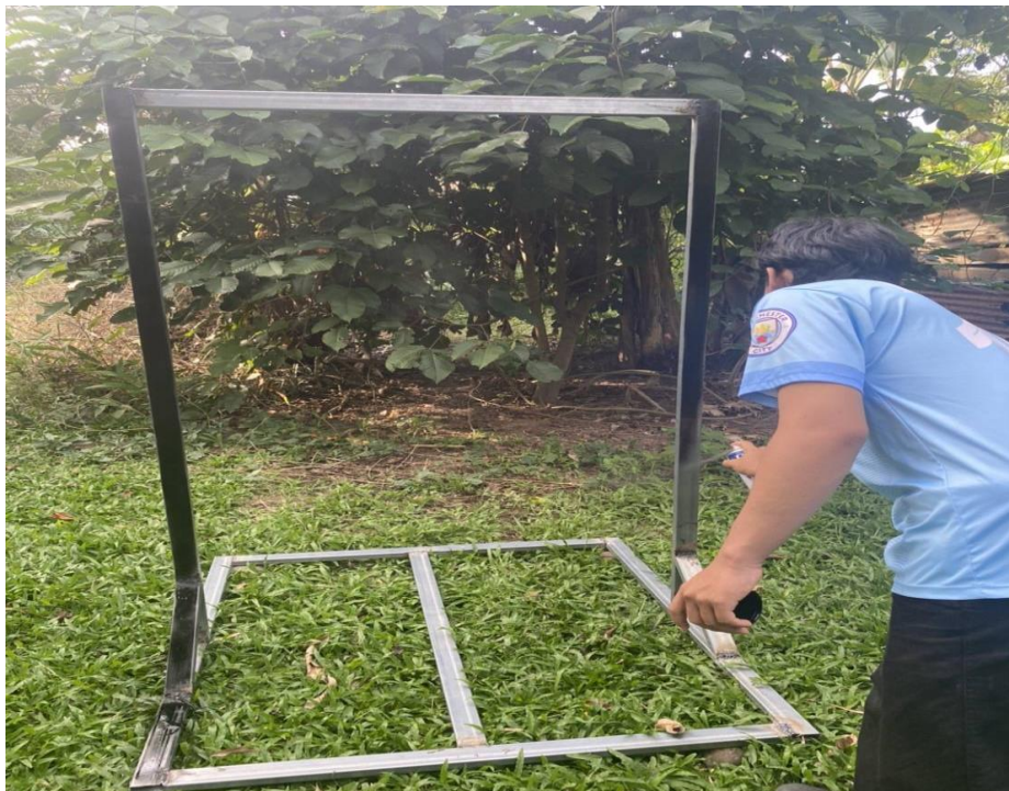
รูปภาพที่ 5 แสดงการพ่นสีเหล็กหลังจากทำการเชื่อมเสร็จ
