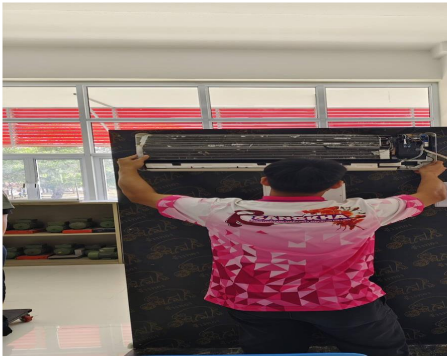
รูปภาพที่ 10 แสดงการติดตั้งชุดแอร์ด้านหน้า
