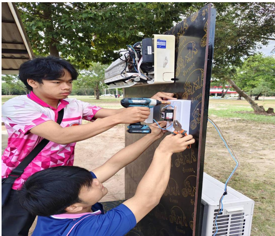
รูปภาพที่ 11 แสดงการติดตั้งชุดแอร์ด้านหน้า
