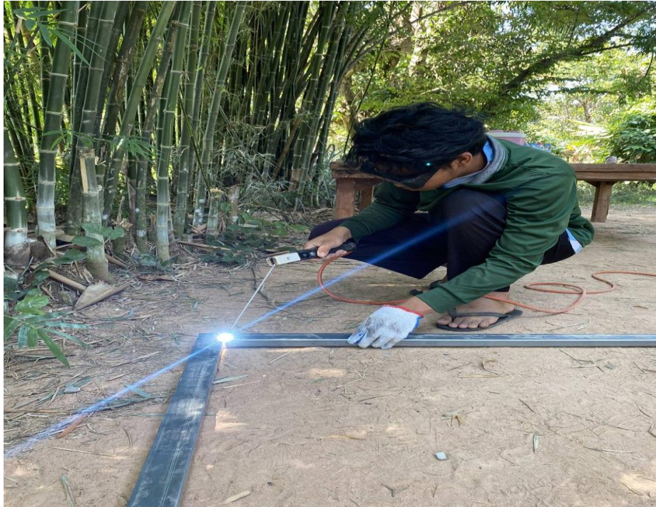
รูปภาพที่ 4 แสดงการวัดขนาดและทำการเชื่อมเหล็กขึ้นโครง
