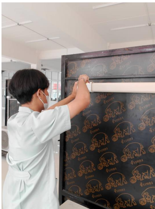
รูปภาพที่ 20 ปิดฝาราง ท่อและสายไฟด้านหลัง
