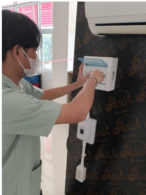
รูปภาพที่ 17 ประกอบและปิดฝา เซอร์กิตเบรกเกอร์
