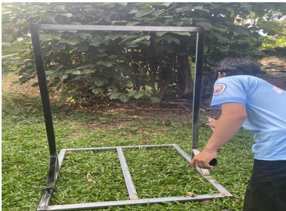
รูปภาพที่ 6 แสดงการพ่นสีเหล็กหลังจากทำการเชื่อมเสร็จ
