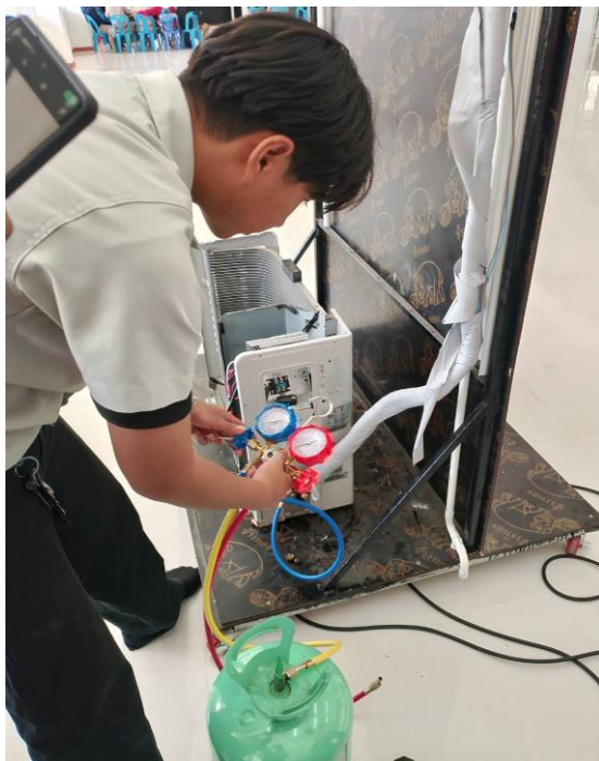
รูปภาพที่ 22 เติมน้ำยาหล่อเย็น และทดสอบการทำงาน
