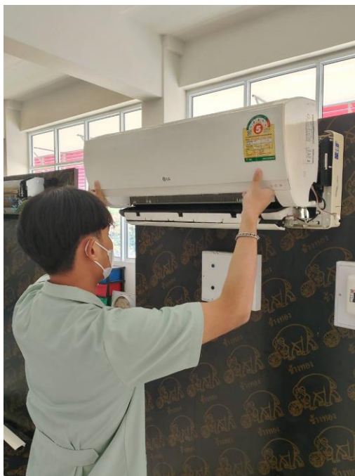
รูปภาพที่ 12 ใส่ฝาคกรอบชุดแอร์ด้านหน้า
