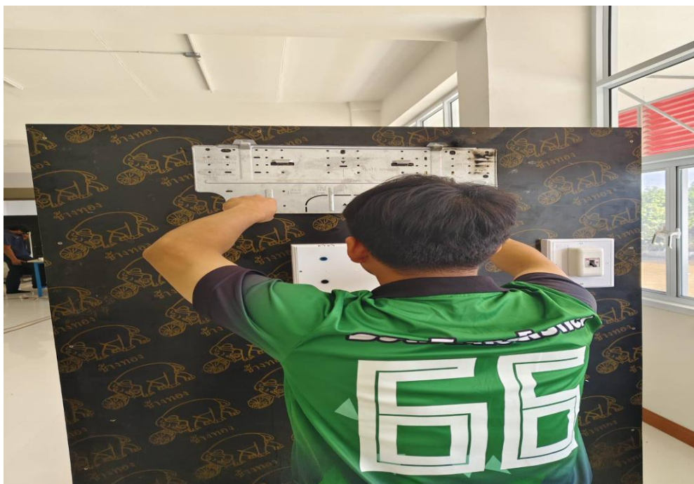
รูปภาพที่ 10 ติดตั้งแผ่นแพลต เพื่อติดตั้งชุดแอร์ด้านหน้า
