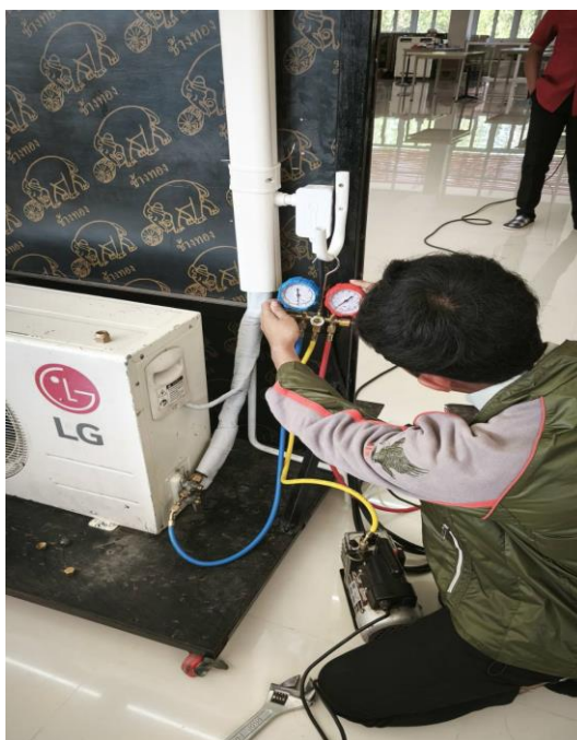
รูปภาพที่ 21 ตรวจวัดซีมิเตอร์วัดดูจุกดรั่ว ก่อนทดสอบการทำงาน
