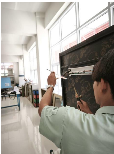
รูปภาพที่ 14 เดินท่อและสายไฟชุดส่วนประกอบแอร์ด้านหลัง
