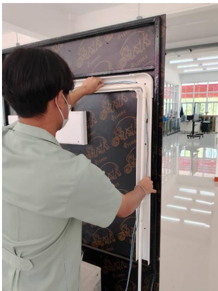
รูปภาพที่ 13 ติดตั้งท่อและสายไฟด้านหลัง
