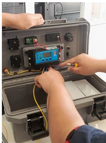
ภาพที่ 3.5 เดินวงจรต่อสายไฟ
